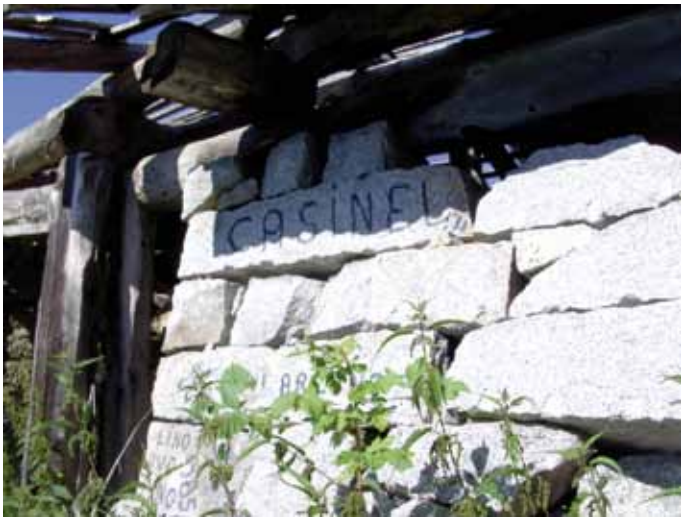
Casinel stato attuale.
