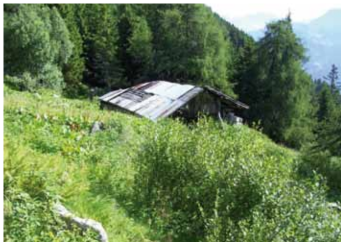
Casinel stato attuale – esterno.
